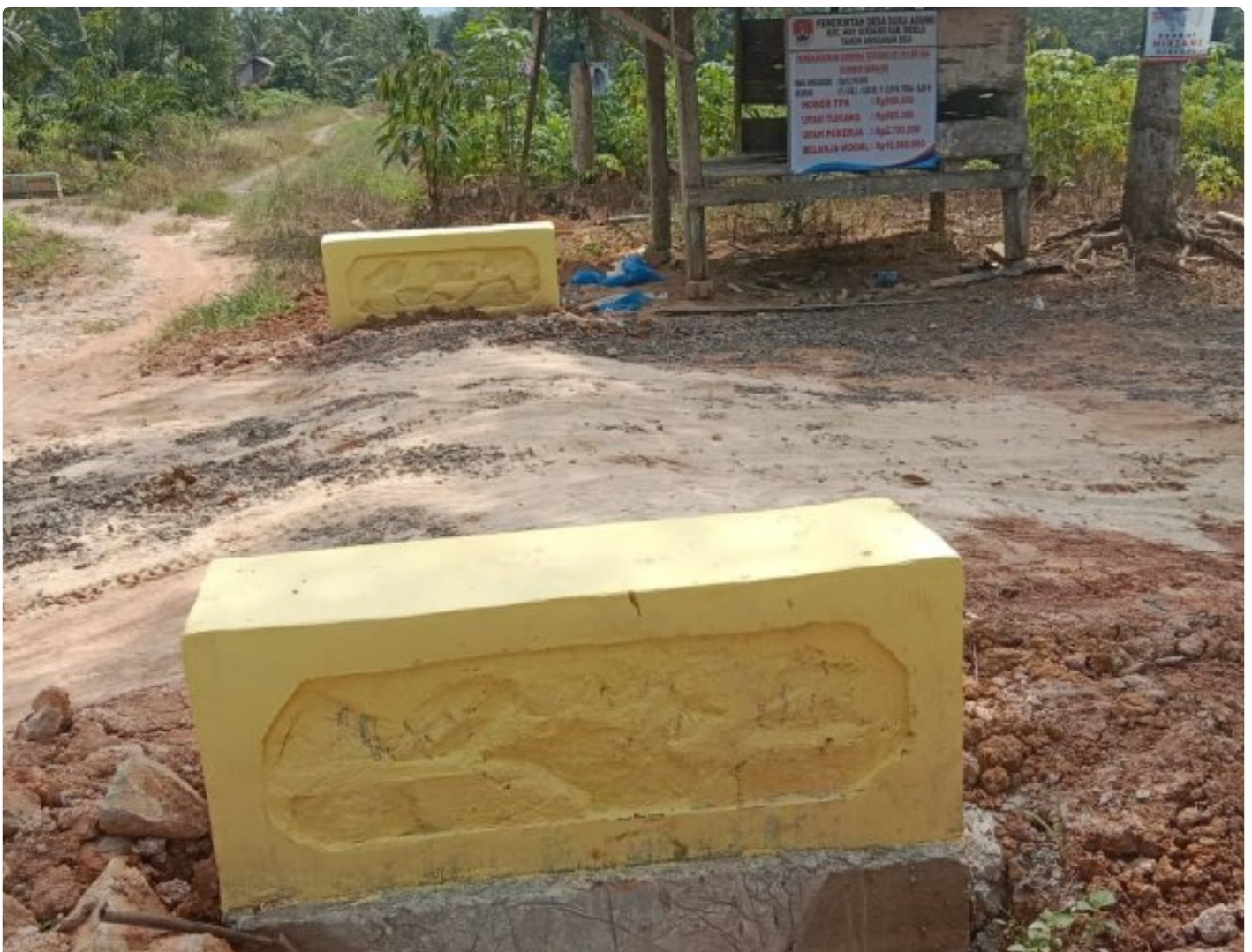
Pembangunan gorong-gorong Desa Suka Agung
